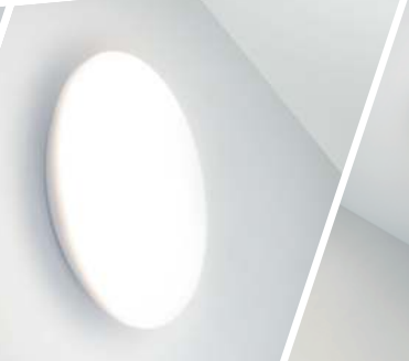
Монтаж на стену
